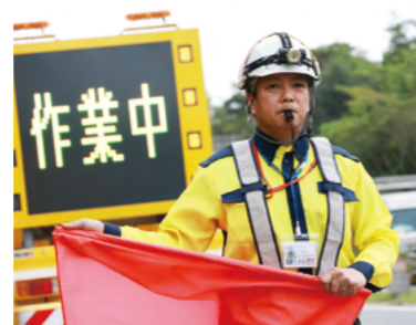
沖縄の陸上輸送を支える沖縄自動車道の保全・点検工事では、安全な交通規制が不可欠です。日々訓練を重ね、確実な警備体制を構築しています。
